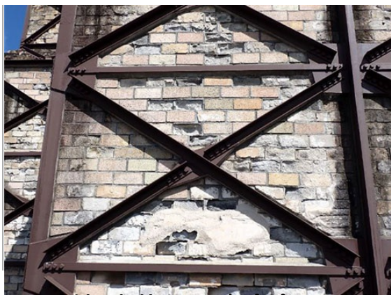
■ 反射炉本体への漆喰塗りの試験施工前後の様子
