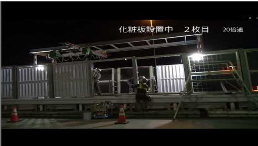
高速道路の遮音壁の施工では、一般車両の車線規制・規制期間の削減による渋滞緩和などが求められることから、施工の合理化が重要となります。しかし、4tクレーン車両を用いた従来の装置では、鉄骨フレームの長さから作業スペースが制限され、遮音壁の取り外しと取り付け施工を同時に行うことは困難でした。
