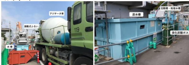
残コン・戻りコン処理システムの稼働状況
