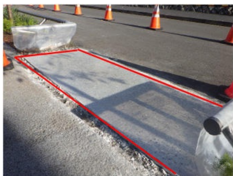
写真4 表面研磨後の現場打ち舗装（全景（左）、拡大（右））
