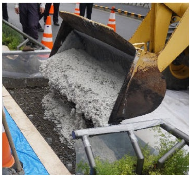
写真3 現場打ち舗装施工状況
