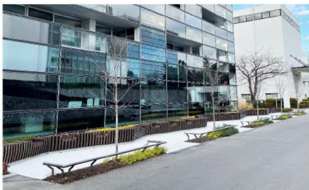
写真5 石材調舗装ブロック設置状況
