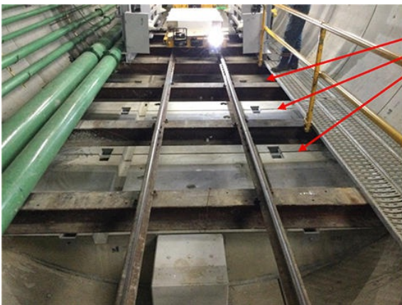
写真3 インバートブロック設置状況
