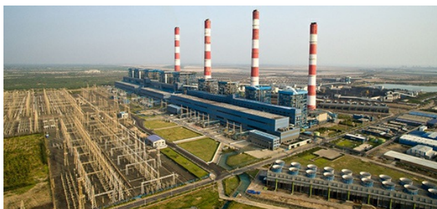
Adani Power Mundra石炭火力発電所
