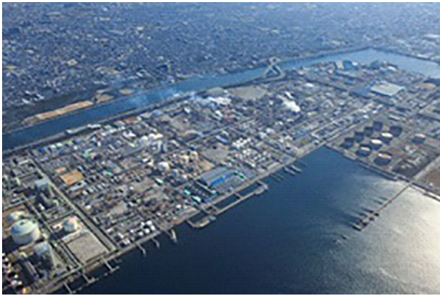
三井化学大阪工場
