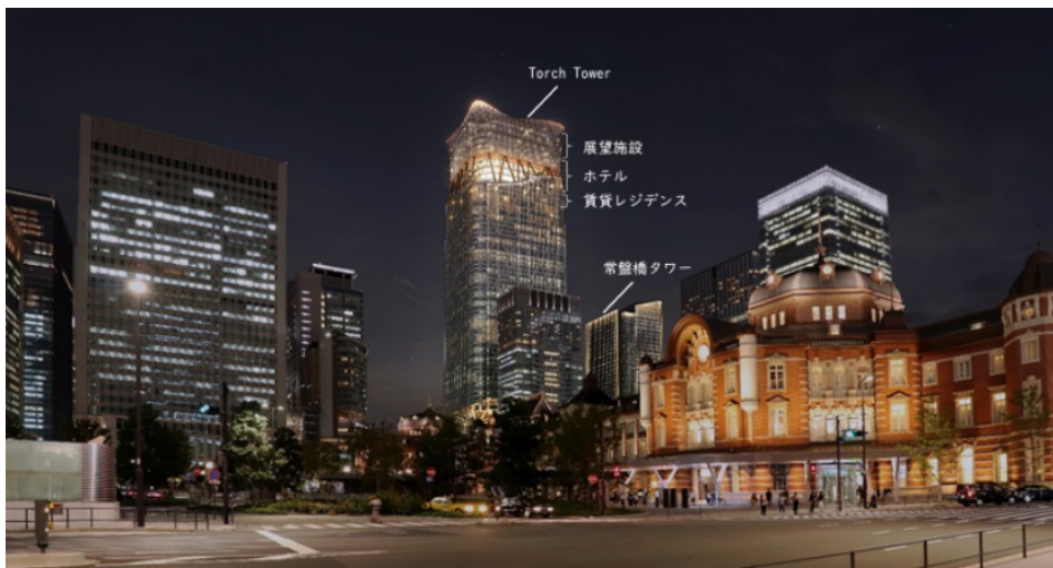
▲街区完成時のTOKYO TORCH Park全景（東京駅側より）
