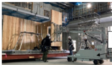
PC 床版上で CLT パネル組立
