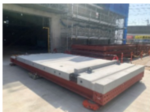
地組ヤードに設置された PC 床版
