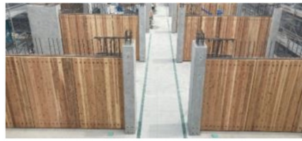
CLT耐震壁の設置状況
