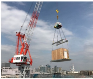
タワークレーンによるユニットの揚重
