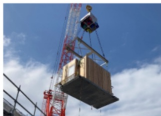
CLT ユニット揚重
