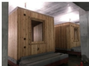
組立て後の CLT ユニット
