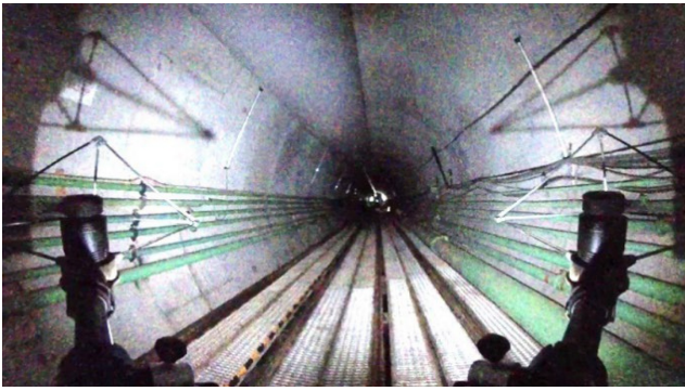
暗所(トンネル)での実証実験状況
