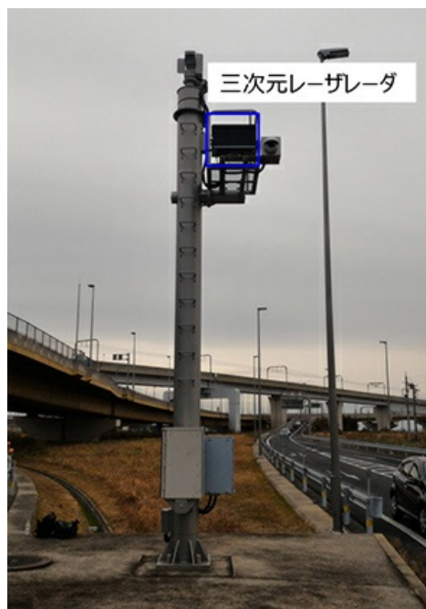
図3：三次元レーザレーダ設置状況
