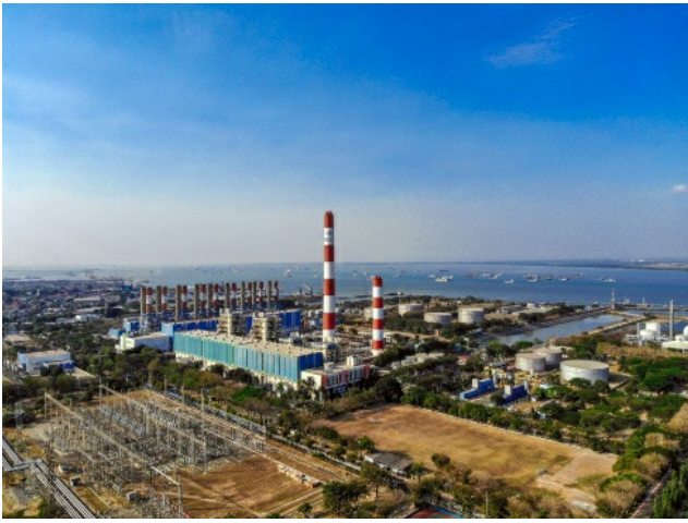
Gresik火力発電所
