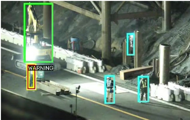
導入現場夜間作業状況へのAIマーキングの動作状況と部分拡大画像
