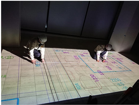
写真4 墨出しの作業状況
