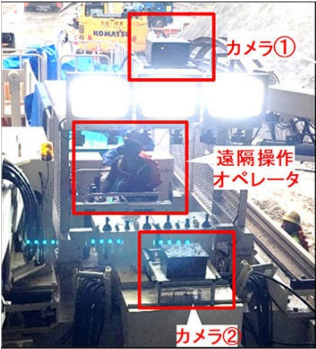
写真 1 カメラなどの設置状況
