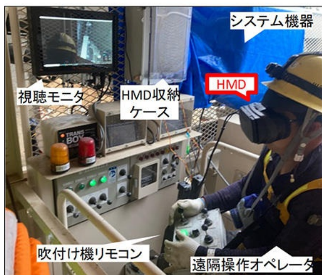
写真2 本技術による遠隔吹付け作業状況
