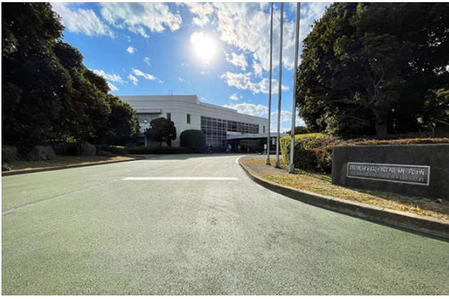
完成した道路（石炭・環境研究所 入口）
